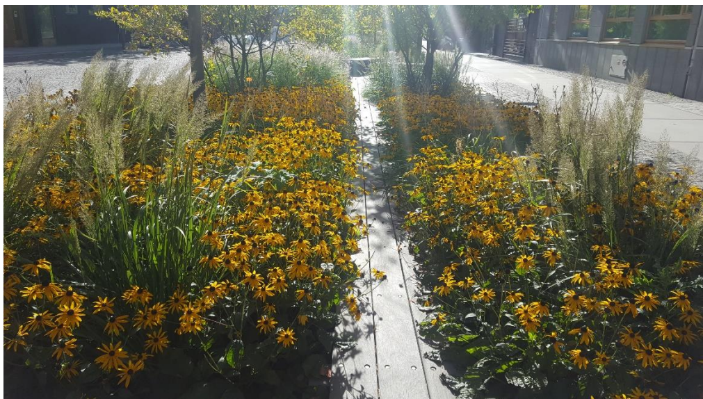
Figur 2 Mindre växtbädd dit dagvatten kan avledas för rening.
